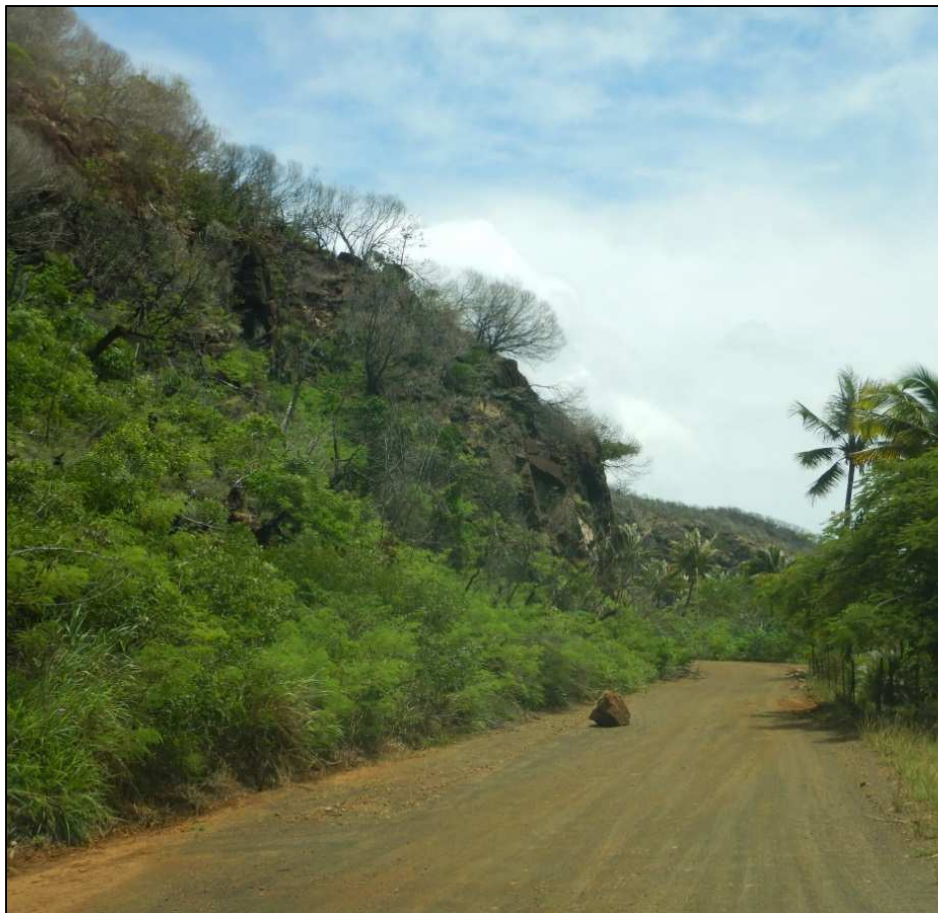
illustration 42 - Exemple de chute de bloc, substrat péridotitique, Poro, route du bord de mer, SGNC 2019
